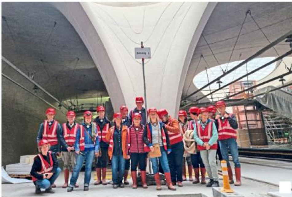
Säerfreunde bei der Besichtigung der S21-Baustelle.
